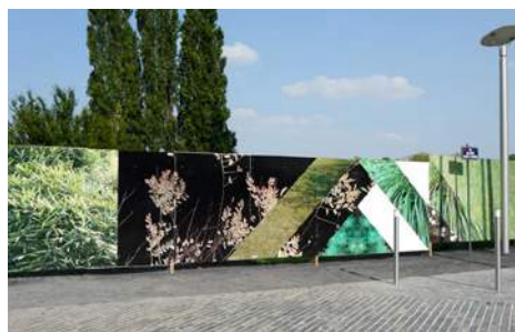
Clôtures de chantier pour la SPL Eurdaille, design: Pomm & Jenny
